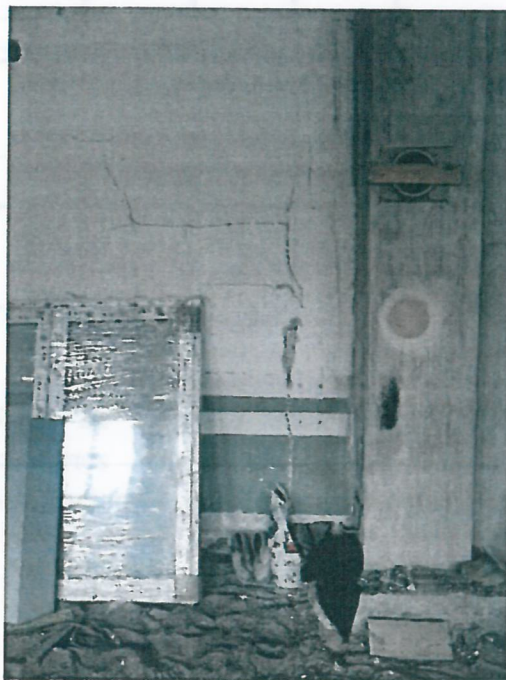
Zdjęcie z wizji lokalnej 2019r. – nowe spękania na warstwie wewnętrznej (gazobeton gr. ~12cm), spowodowane prawdopodobnie nieostrożnie prowadzonymi pracami rozbiórkowymi posadzek wewnątrz budynku.
